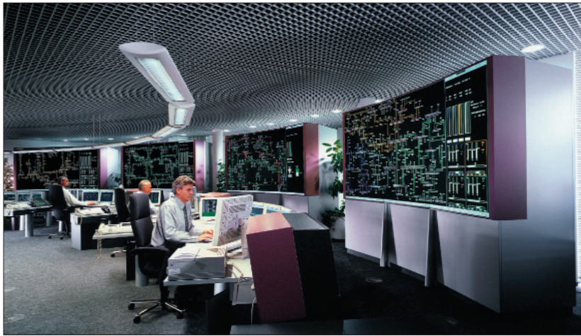
Schaltleitung Arnsberg: Netzfürer des 110-kV- und 30-kV-Netzes im nördlichen Gebiet der Westnetz GmbH
